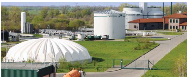
Kläranlage der Stadtwerke Prenzlau
